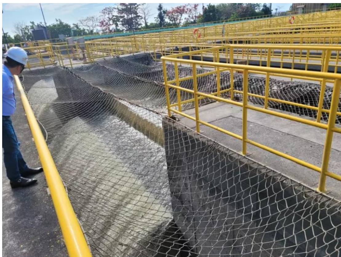
圖一:上圖為高雄汙水處理廠，每日汙水處理量約50萬噸，落差3.5公尺具有開發水力發電的潛力，但大型汙水處廠數量稀少，難以推廣。
