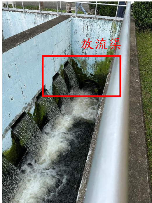
圖七:放流區現場照片2
